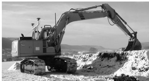
3D navigacijski sistem podjetja TOPCON omogoča avtomatizacijo pri zemeljskih delih
