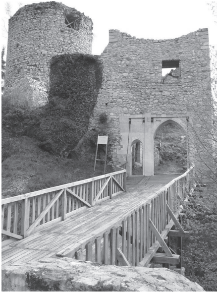
Slika 1: Rešitve pri obnovi podrtega vhoda v grad Žounek so vzpodbudile največ komentarjev, Igor Cergolj, OGU Ljubljana, 2008.
