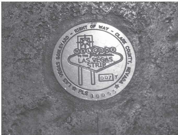
Slika 2: Mejno znamenje, ki označuje mejo javne površine v Las Vegasu, s številko odgovornega geodeta.
