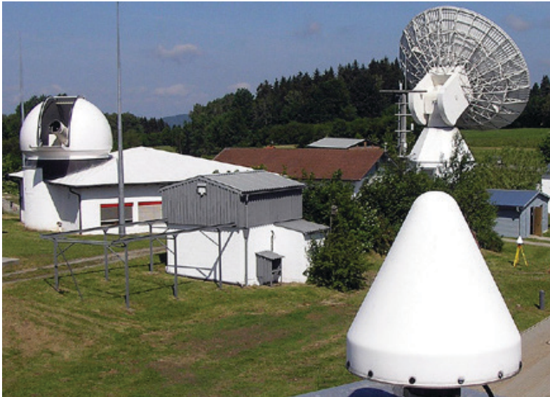
Slika 9: Geodetski observatorij Wettzell: laserski teleskop (kupola levo) za merjenje razdalj do Lune in umetnih satelitov (LLR/SLR), radijski teleskop (zgoraj desno) za dolgobazno interferometrijo (VLBI) ter (v ospredju) GNSS-antena (vir: Schlüter in sod., 2007).
