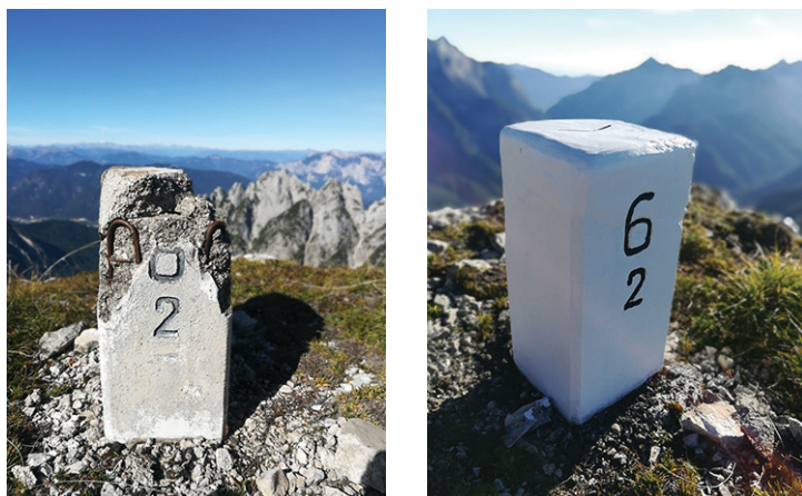
Slika 2: Primer poškodovanega (levo) in obnovljenega (desno) mejnega znamenja (foto: K. Medved).
