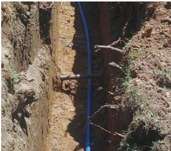
Slika 4: ‘Križanje’ starega (črna cev) in novega (modra cev) vodovodnega priključka na globini enega metra. Foto: Joc Triglav, julij 2020.
