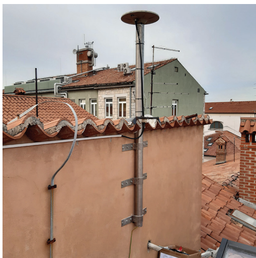
Slika 1: GNSS-antena na strehi objekta (levo), omarica za sprejemnik in telekomunikacijsko opremo (desno).
