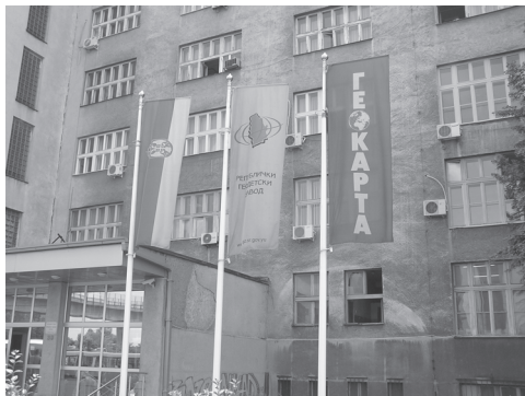
Slika 4: Pročelje zgradbe RGZ Srbije.
