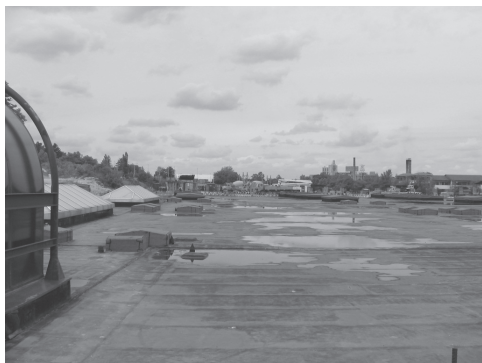
Slika 5: Armiranobetonska ploščad železniške postaje, nad katero se bo zgradil trgovsko-poslovni center.
