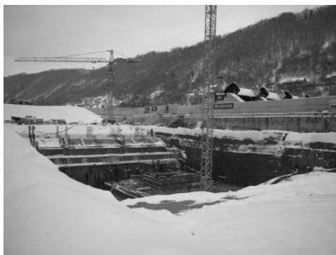
Slika 2: Gradbišče HE Krško
