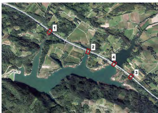
Slika 4: Lokacije prepustov pod HC Selo–Šempeter na območju zadrževalnika Vogršček (objekti 1, 2 in 3) ter lokacija pretočnega objekta iz zgornjega v glavno jezero (objekt 4) (vir: DOF 2010, GURS; izdelava slike: Matjaž Tratnik).
