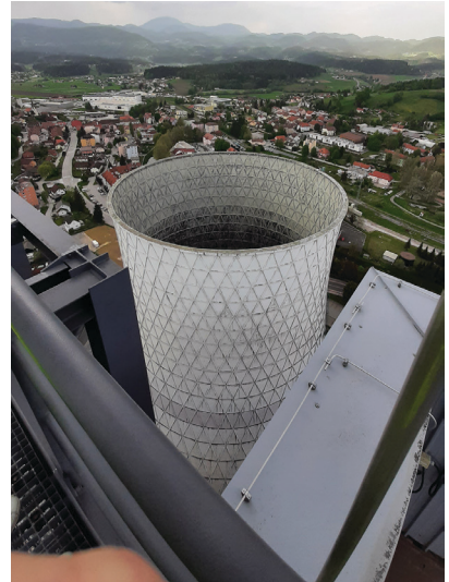
Slika 4: Hladilni stolp bloka 4 z razgledne ploščadi TEŠ, v ozadju Šoštanj (foto: Sara Šopar).
