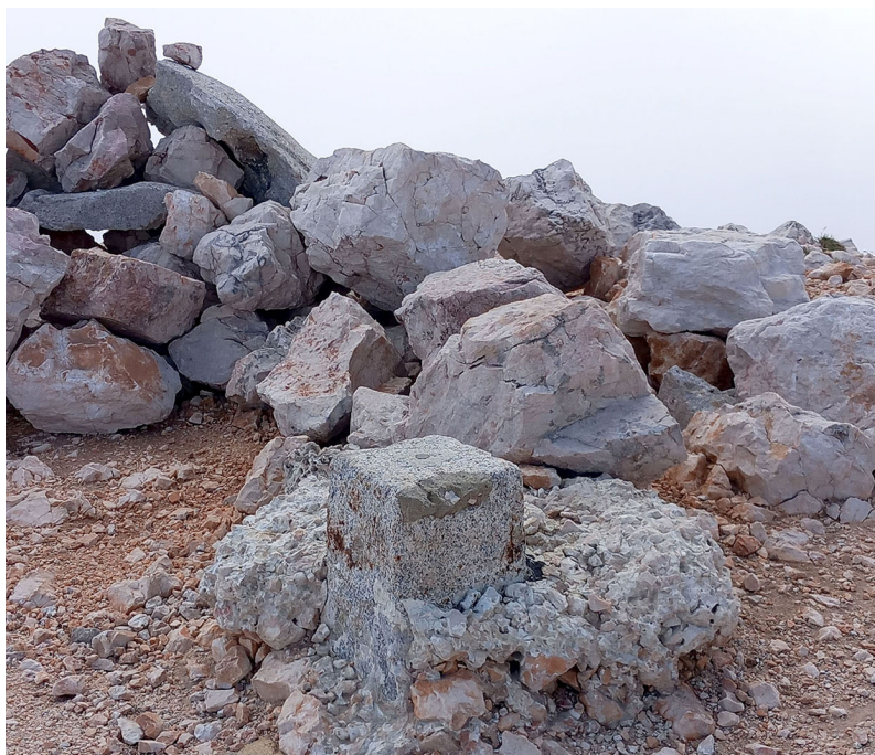
Slika 2: Stanje trigonometra (167z1) pred pričetkom obnove.
