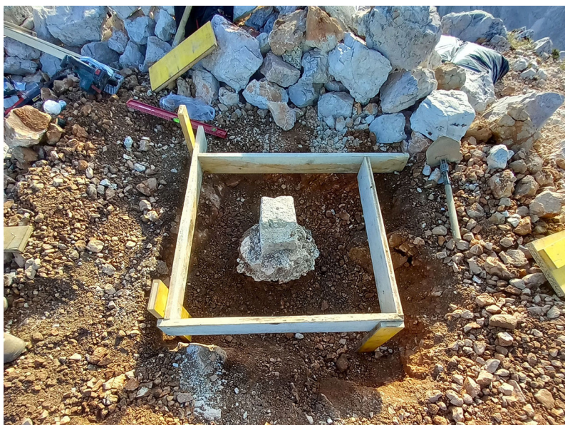
Slika 5: Izkop za novi temelj trigonometra (167z1) in namestitev opaža.
