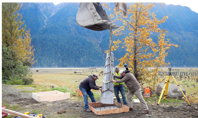
Slika 9: Na sliki geodeti postavljajo nov državni mejnik na mejno črto. Za vzdrževanje in obnavljanje več kot 8000 državnih mejnikov in več kot 1000 točk geodetske mreže na državni meji ter za redno čiščenje mejnega pasu med Kanado in ZDA je zadolžena meddržavna mejna komisija (Mejna komisija, 2025).
